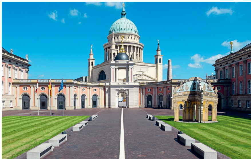
Blick in den Innenhof des Landtages mit dem Fortunaportal und der Sankt Nikolaikirche.
